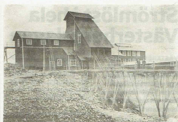
Gruvan sedd från söder med gråbergsbanan på stativ. Bakom skymtar hundbanan, uppföringen från schaktet till laven.
