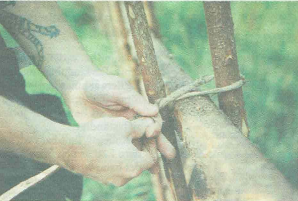
Gårdslena binds fast med hjälp av vidjor, tillverkade av kluvna smågranar.
