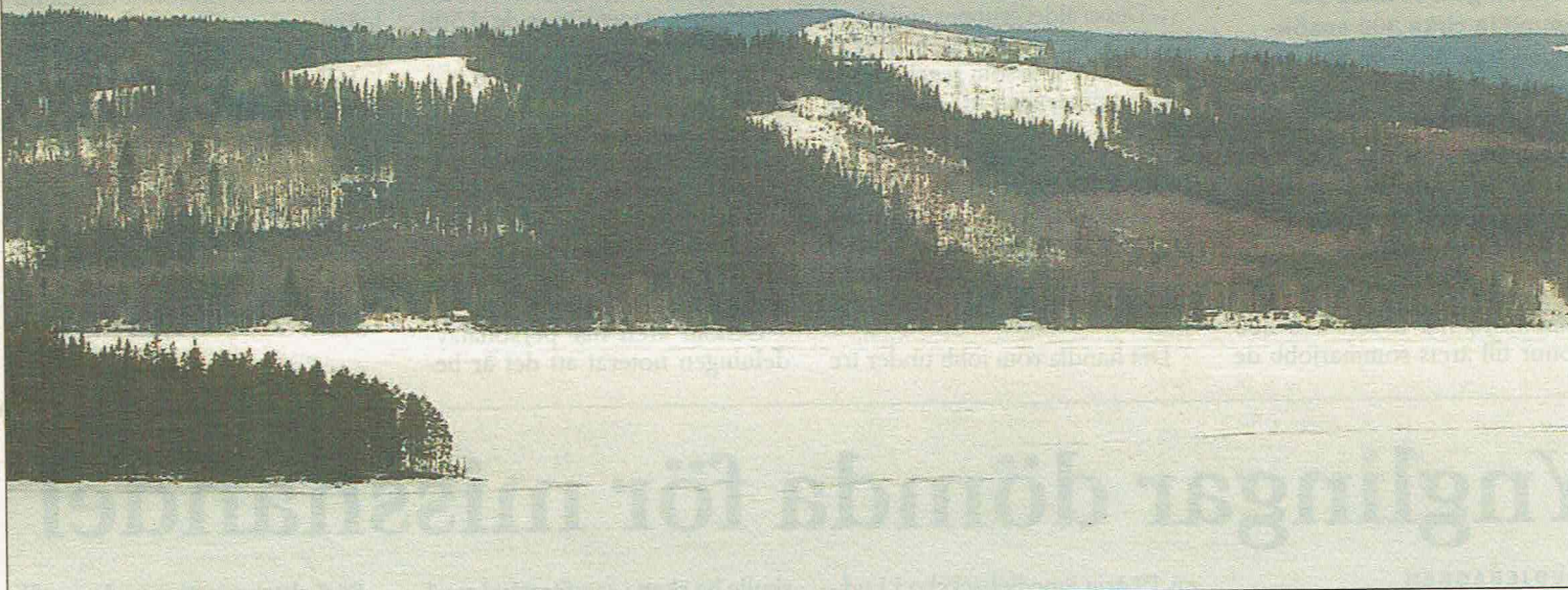
Massor av kraft. Byggs det tio vindkraftverk där på andra sidan Väsman kommer de att ge intäkter på cirka 30 miljoner per år. Därav väntas Stena Adactum att reservera 0,5 procent eller 150 000 i så kallad bygdepeng. Bilden tagen från Lekombergs utsiktsplats.
