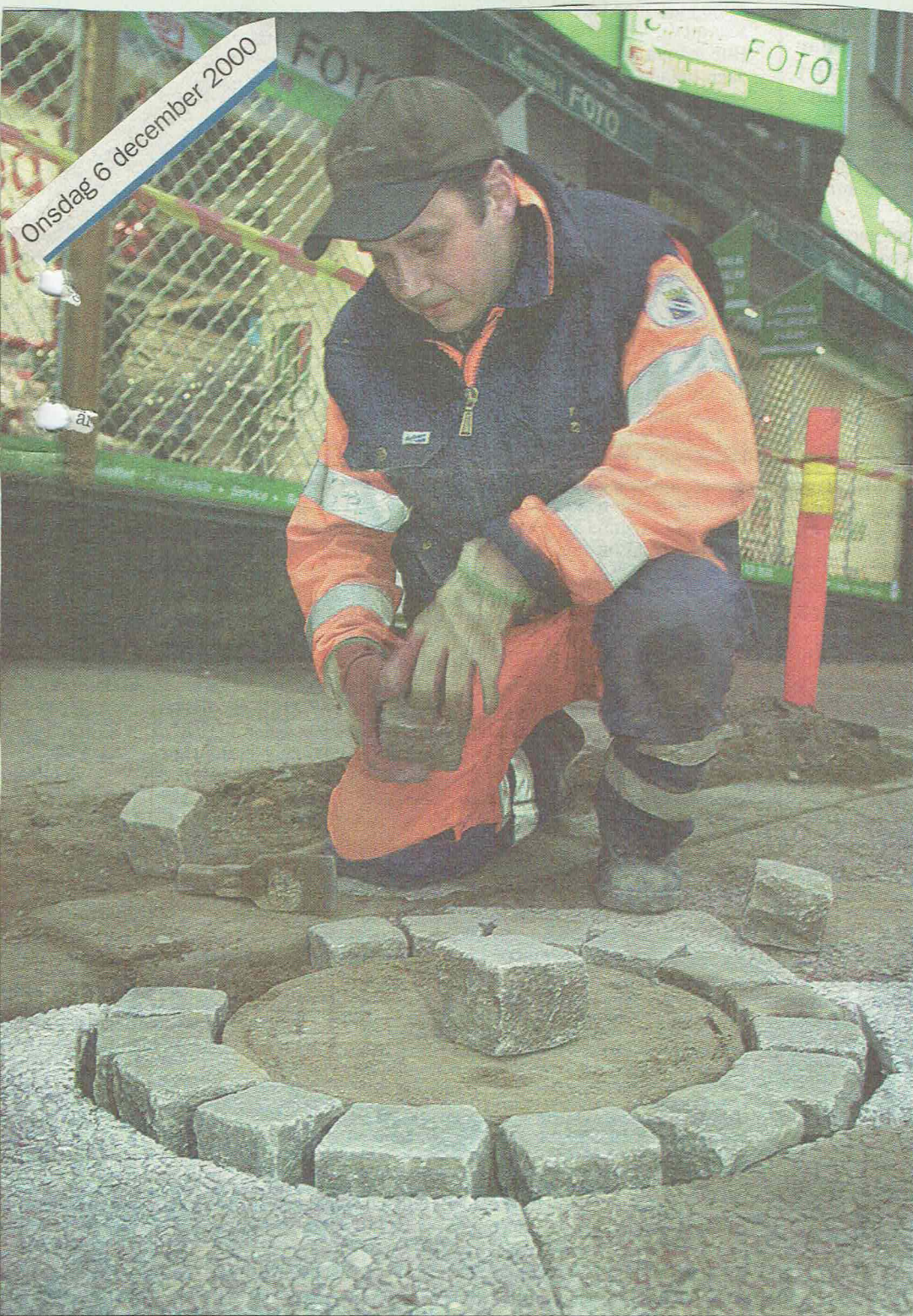
Stenläggning. Ove Heed ägnar denna udda december åt att lägga plattor och gatsten på Storgatan, något som normalt inte hör årstiden till.
