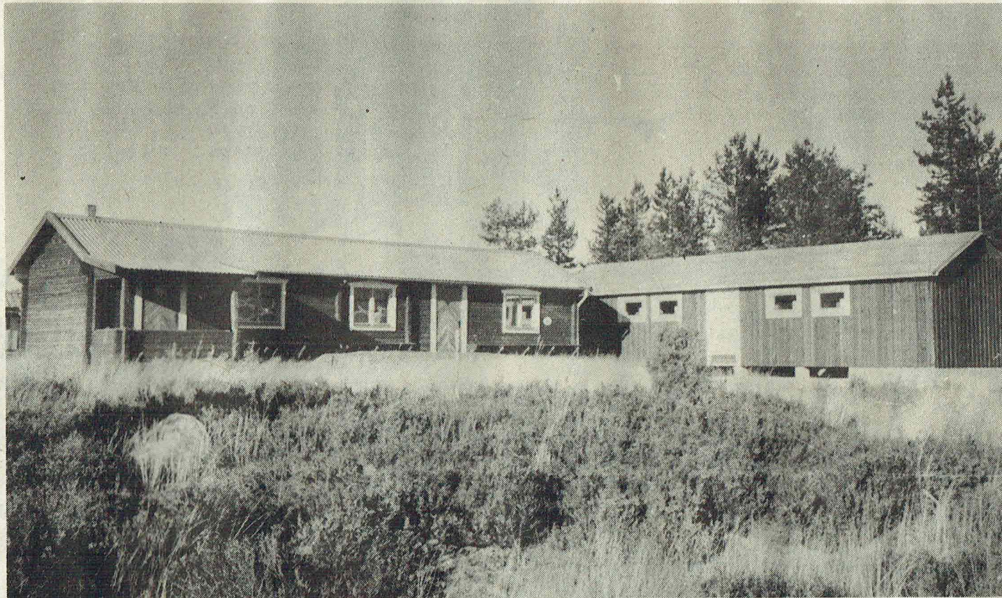
En sk värmestuga — till höger på bilden — utgör nybyggnad vid Ljungåsen väster om Grängesberg och som påbörjades som AMS-jobb på försommaren. Nu finns inga arbetslösa byggnadsarbetare men kommunen planerar att bygga färdigt med eget folk. Idag kan inte heller den förutvarande stugan användas då här placerats isoleringsmaterial till nybygget!
