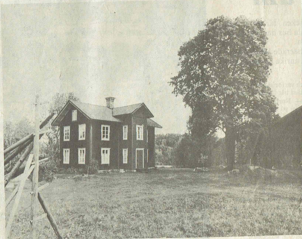
Finngården, den gamla och kulturhistoriskt intressanta gården kommer att hamna ett femtiotal meter från det planerade villaområdet.
