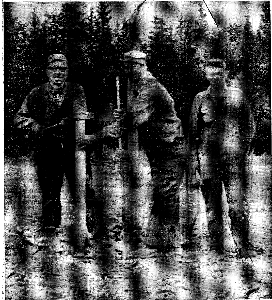
Tre man som var med vid starten av Lastbilscentralens bygge i Grängesberg var Johan Orré, Saxdalen, Valter Lagerkvist och Frank Karlsson, Gonäs. Dom sysslade med utsättningar för det kommande bygget.
