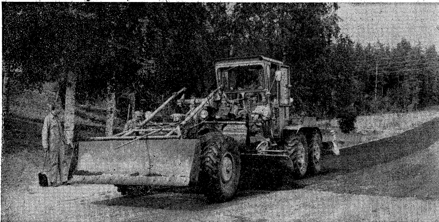
För att den nya permanenten skall komma till sin rätt krävs det ganska omfattande förarbeten och här är man i färd med att jämna ut gropar och svackor.
