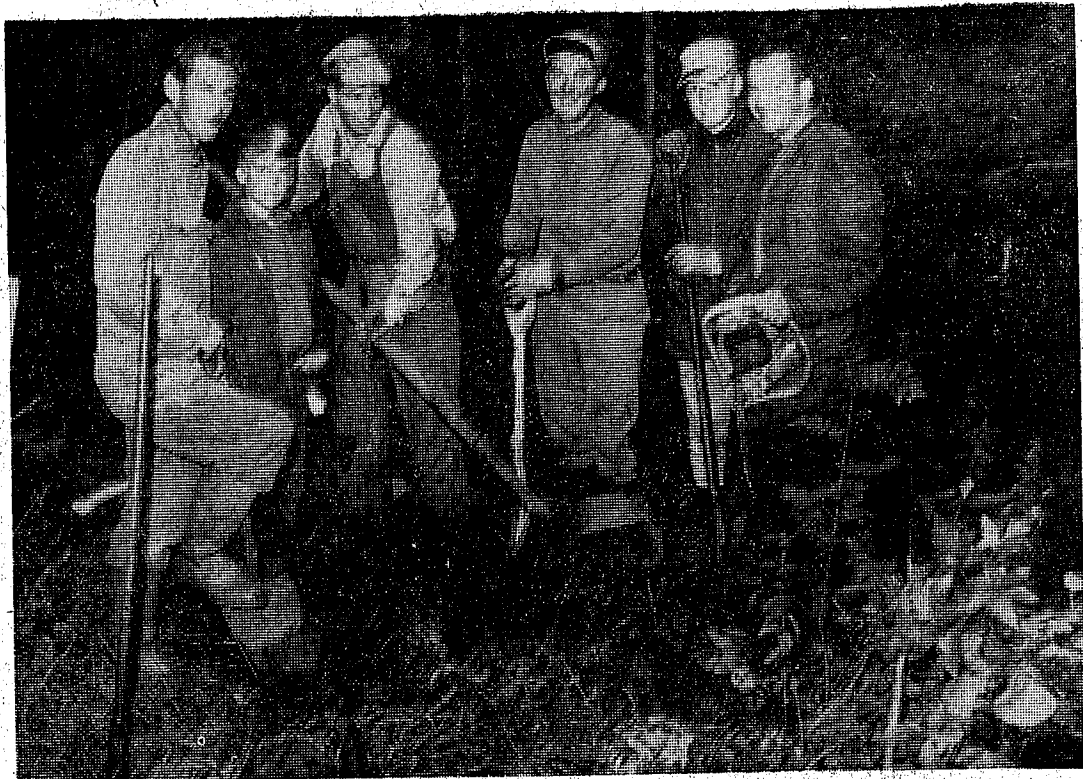
En del av de frivilliga jobbarna vid stolphålsgrävningen. Fr. v. Elof Bark, Grängesberg, Jens Heij, Göte Byström, Olle Wallman, "bas för bygget", Lars Göran Karlsson och Rune Heij som gick snabbt fram med motorsågen
