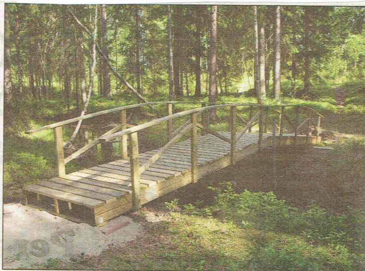
...och efter föräldrainsatsen har en ny och fräsch bro med räcken byggts.
